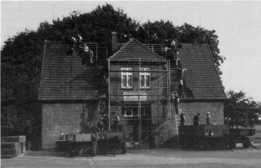
Die ehemalige Schule erhält ein neues Dach
